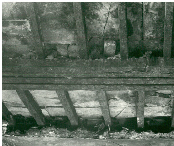
Die Treppenkonstruktion von unten
