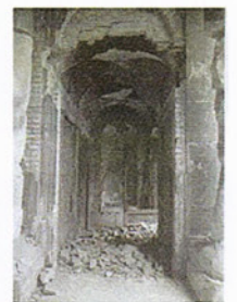
Grotengang mit Kreuzgewölbe, 1950
