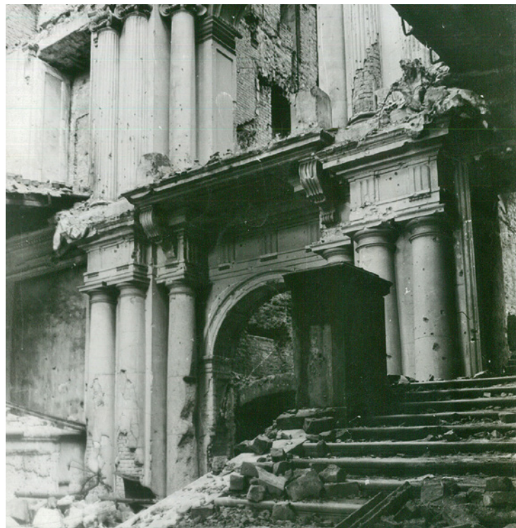
Teilansicht des ausgebrannten, aber wiederaufbaufähigen Treppenhauses
