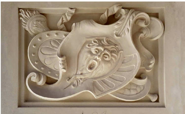
Armatur der Kassettendecke im Durchgang
