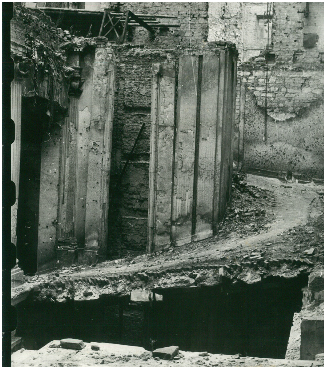
Ein technisches Wunder für die damalige Zeit. Die geniale Eisenkonstruktion ermöglicht einen freitragenden, sehr dünnen Treppenaufbau.
